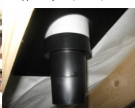
В комплект входит адаптер с диаметром \varnothing 125 - \varnothing 110
